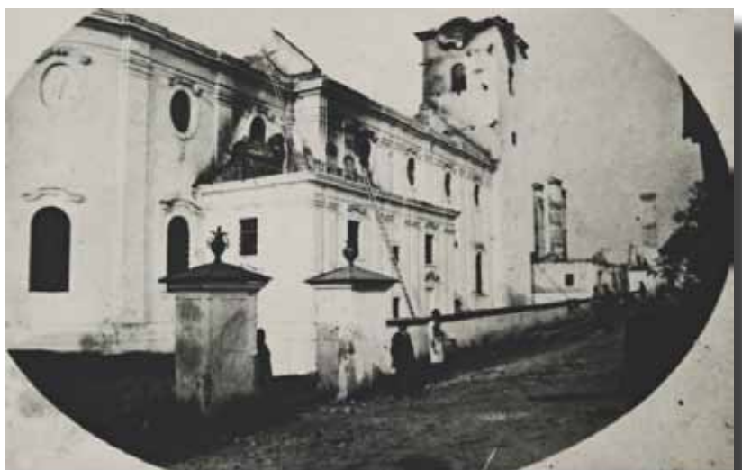
Kirchenbrand 1891 - die Brandruine (gesehen von der Straße)
