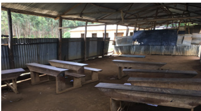
Hier ein Bild der bestehenden Schule
